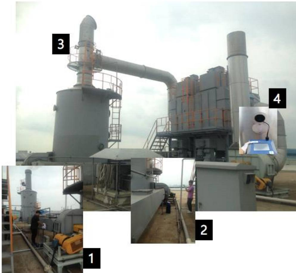
그림 31. EFC장치 광산란 및 시료채취 장소, 1: 유입부 좌측, 2: 유입부 우측, 3: 전단S/C 배출부, 4: EFC 출구>
